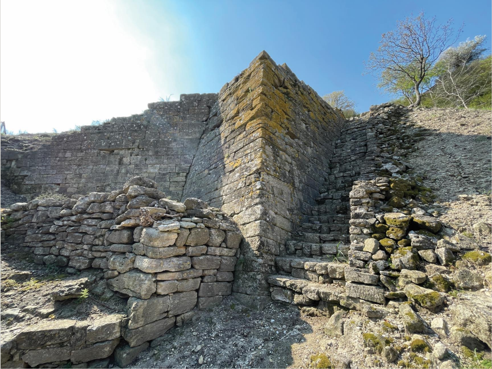
Günümüzde Kuzeydoğu Bastiyonu
