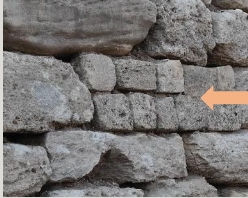
Restorasyon için eklenen küçük taşlar.
